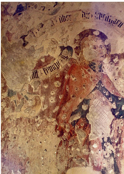
Die Wände wurden mit der Hacke aufgeraut, damit der Gips danach besser hielt.
