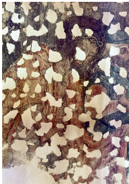
Bei der Renovation 1975 wurden die Löcher aufgefüllt und.....
